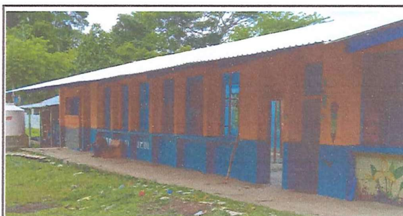
Foto 4: ya terminado el techo sin pintar paredes
