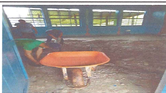
Foto 2: trabajos en piso
