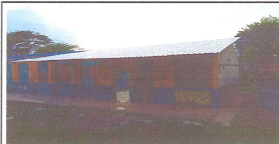
Foto 6: a media construcción de techo
