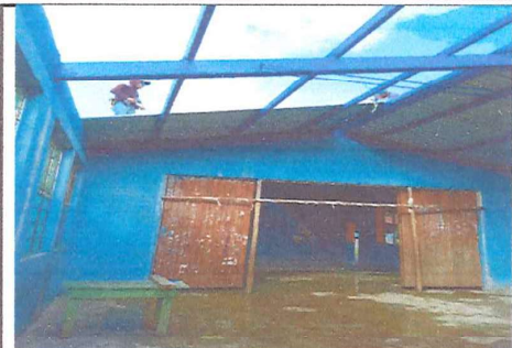
Foto1: Colocación de entechado
